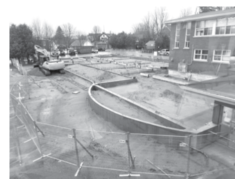
Un aperçu de l'avancement des travaux dans la cour Photo : Marie-Claude Gauthier
